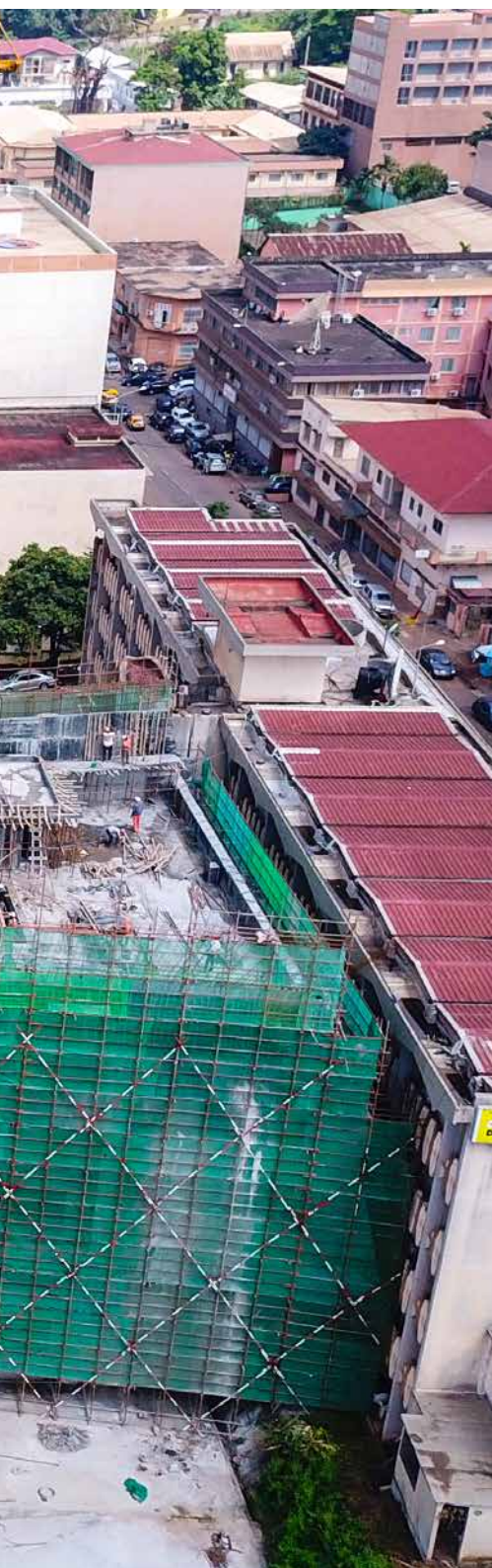
immeuble de la DGI
