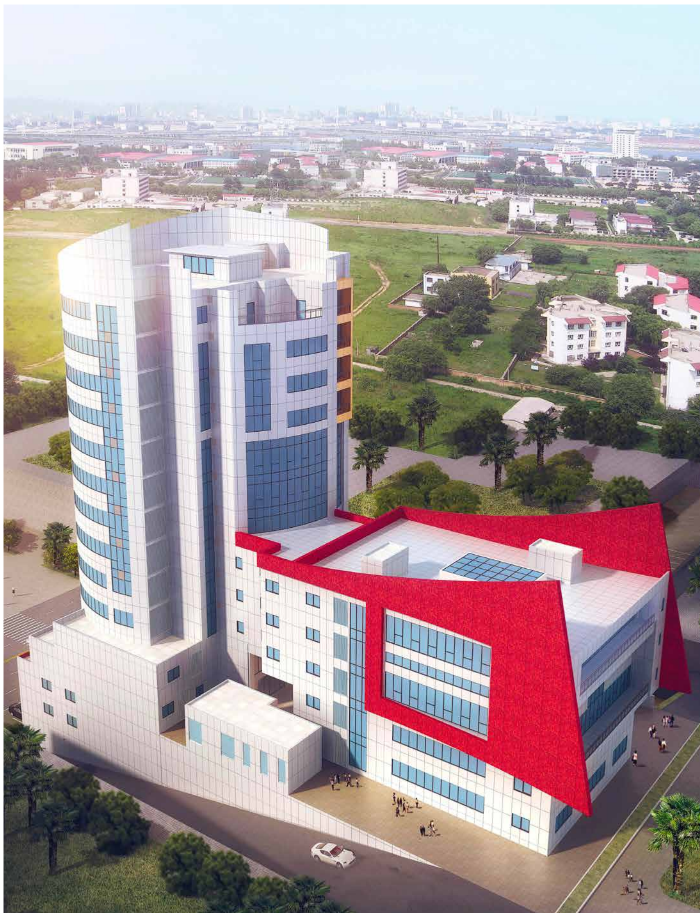
Vue de profil du futur immeuble de la DGI
